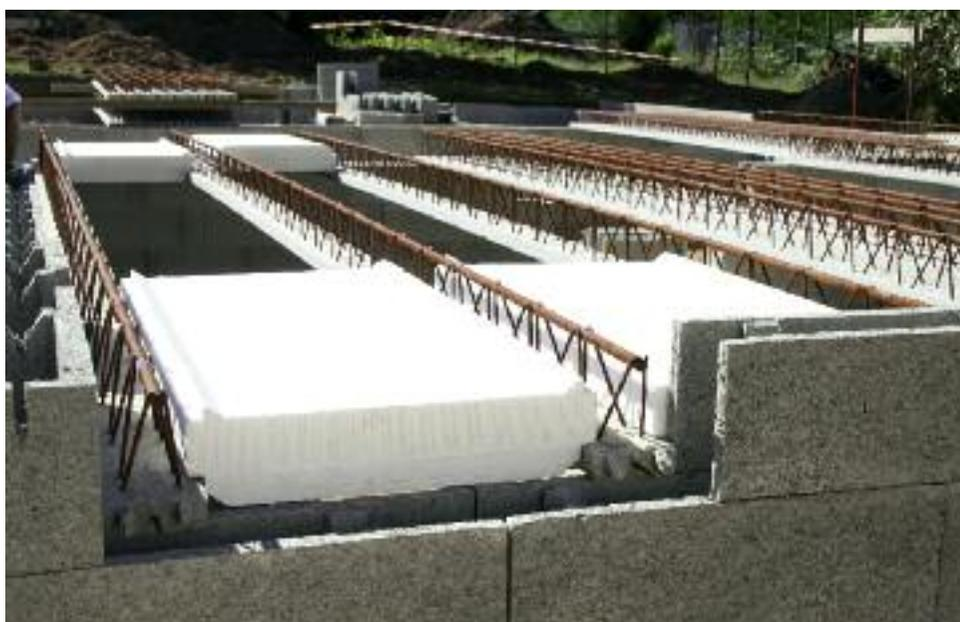
Pour compléter ces données, notons que ces poutrelles de nouvelle génération permettent de franchir une portée de l'ordre de 6.50 m, dans les mêmes montages avec entrevous polystyrène que ci-dessus et ce avec UNE SEULE file d'étai...
