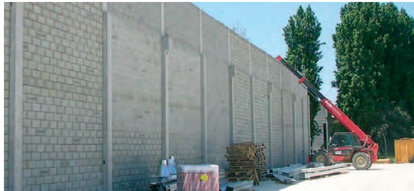
Mur coupe-feu 3 heures en blocs de 20 sur le chantier d'un centre commercial à Gennevilliers (92), réalisation de l'entreprise Brezillon.
